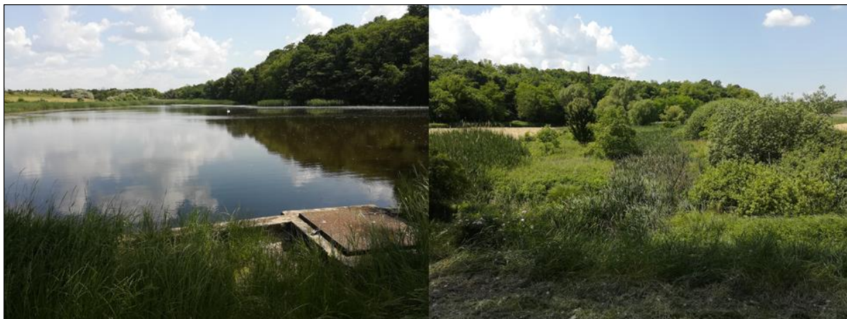
45. ábra Az V. számú tó völgyzárógátja (E5. műtárgy) és a Csíkgáti-árok medre az V. számú tó alvli oldalán (2023.06.02)
