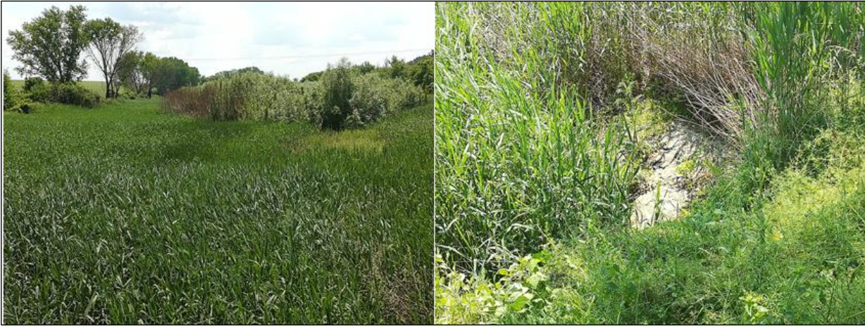
33. ábra Az Enyingi-tározó a 0141 hrsz. út alatti áteresztő alvizi oldalán (2023.06.02.)
