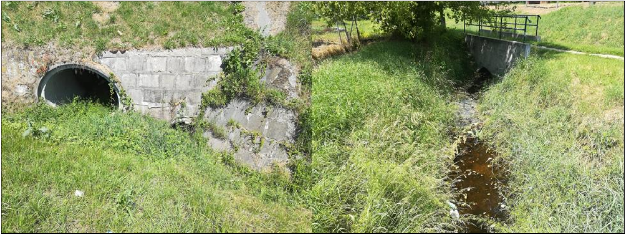
38. ábra Az Enyingi-ér 64. főút alatti áteresze (B14. műtárgy) felvízi oldala és a gyaloghíd (B15. műtárgy) felvízi oldala (2023. 06.02.)
