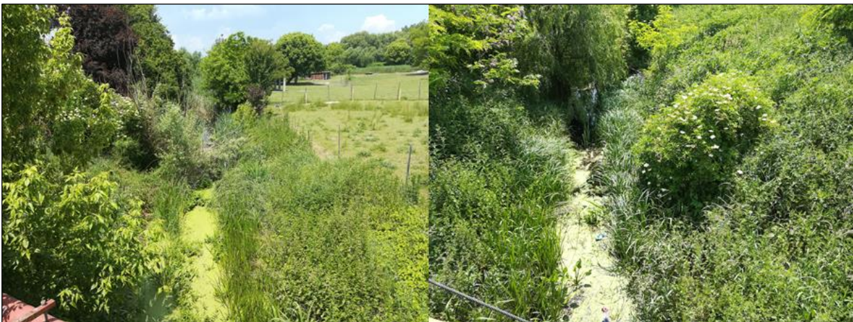
30. ábra A 10+929 km szelvényben lévő közúti híd (A11. műtárgy) felvízi és alvízi mederszakasza (2023.06.02.)
