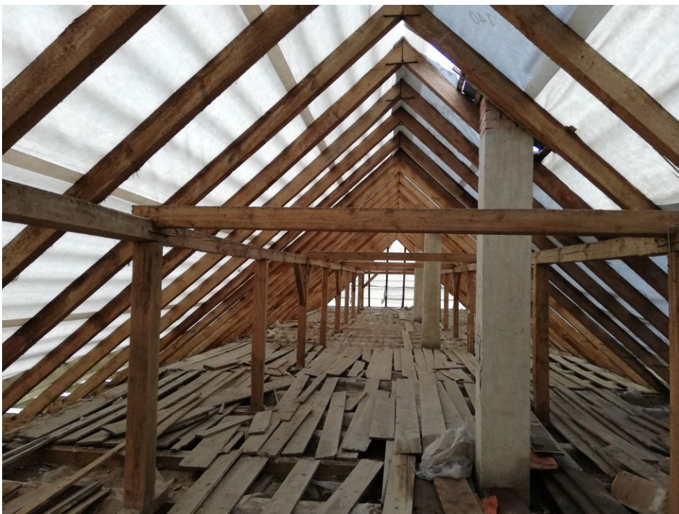
4. ábra: Tetőszerkezet és fafödém
